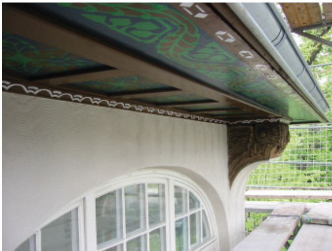
Kammzugputz – Caspar David Friedrich Straße in Dresden
